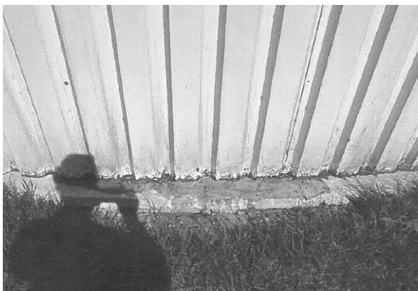
Udsivning fra rådnetank 4.
