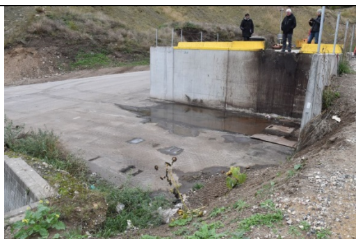
Plads for container har bagfald, så der ikke er afløb til kloakrist i NV-hjørnet.
