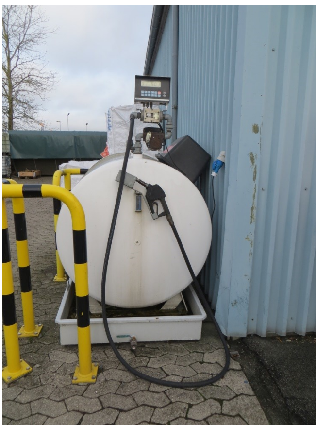
Figur 7. Dieselolietank med spildbakke. Afløbsstuds gør det vanskeligt at tømme spildbakken for regnvand.
