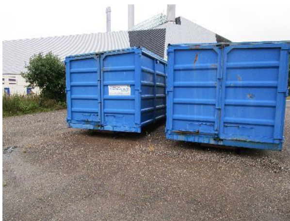
Opbevaring af olieholdige spåner i containere med låg og dobbeltbund vest for bygning
