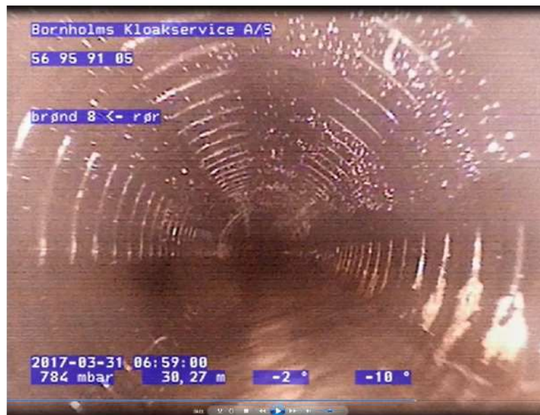
Figur 6 Anlæg C. Drænledning tilsluttet brønd 8 (r_r). Fint cirkulært rør
