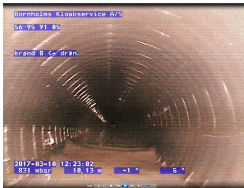
Figur 5 Anlæg A. Drænledning tilsluttet brønd 8 (dr_n). Fint cirkulært rør.
