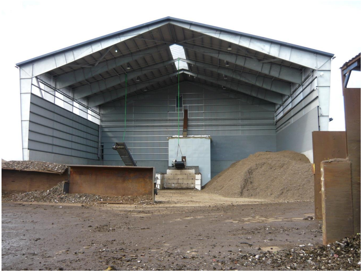
Figur 11: Raff2 åben gavl mod øst med materialeudkast og kværn
