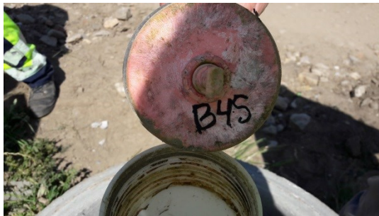
Figur 3 Grundvandsboring 4s med formodet DGU-nummer 107.1731
