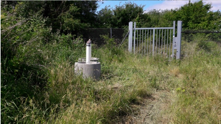
Figur 5 Grundvandsboring 9s med formodet DGU nummer 107.1738, samt perkolatbrønd nr. 9.
