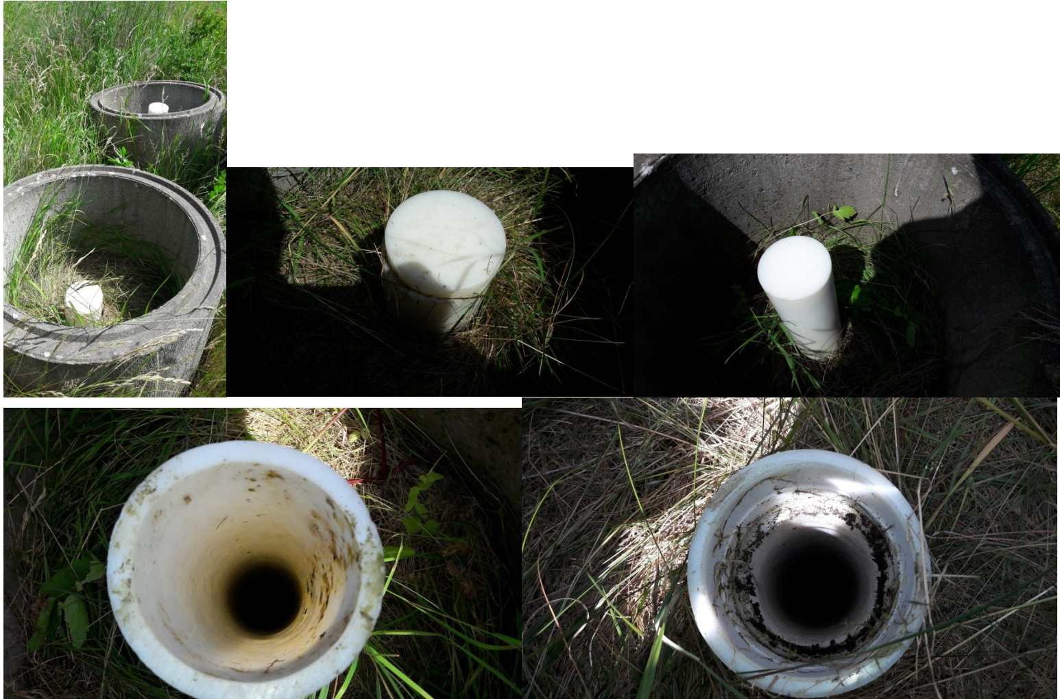
Figur 7 Perkolatbrønd nr. 71 og grundvandsboring 71s med formodet DGU nummer 170.1725 propperne sluttede ikke tæt. Der var ikke mærkning, så det var ikke muligt at vurdere hvilken der var til grundvand og hvilken der var perkolatboringen.
