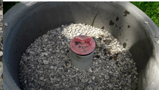
Figur 8 Perkolatbrønd 72 og Grundvandsboring 72s med formodet DGU nummer 170.1730. Det er grundvandsboringen, der er den høje af rørene.
