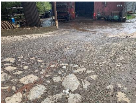
Belægning ved nedkørsel til værksted.
