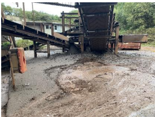
Belægning under shredder med meget støv.
