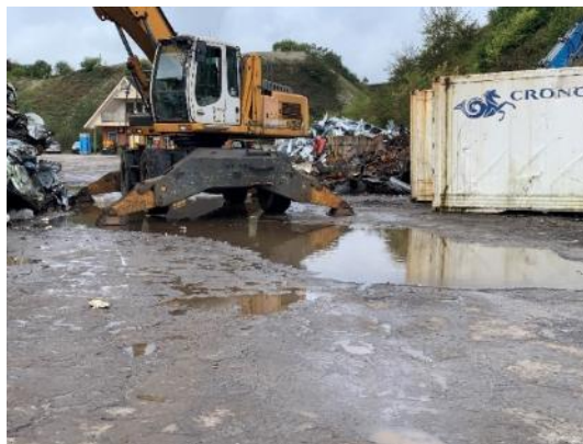
Belægning ved formaterialer med stillestående overfladevand.
