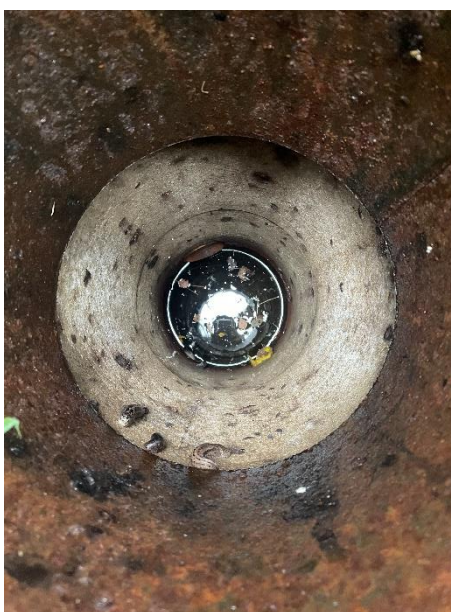
Foto 9a og 9b: Brønd 4, som har kontakt til det terrænnære grundvandsmagasin. Af 9b ses at grundvand siver ind i brønden i sprækken mellem 2 brøndringe nederst til venstre.
