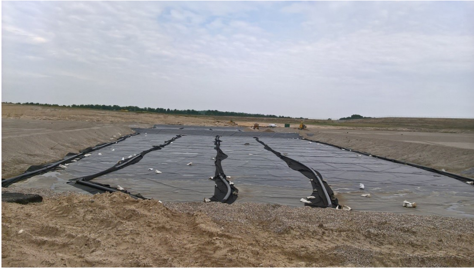
Billede 1: Udlagt plastmembran
