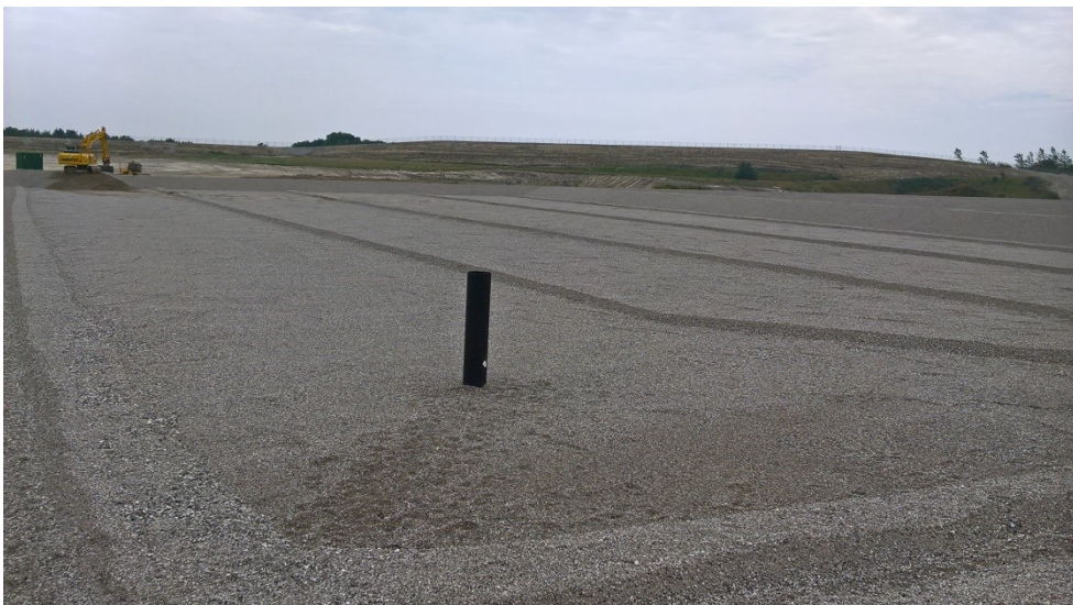
Billede 2: Brønd med tryktransducer for registrering af perkolatstanden i deponeringsenheden.
