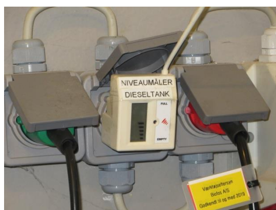
Billede 8: Overfyldnings-sikring
