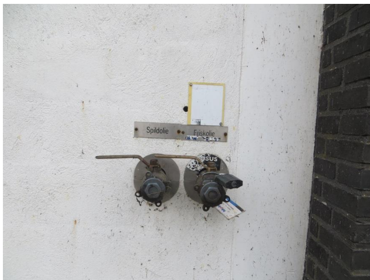
Billede 10: Studse til påfyldning af tanke i gasmotorrum og aftapning af tank i gasmotorrum
