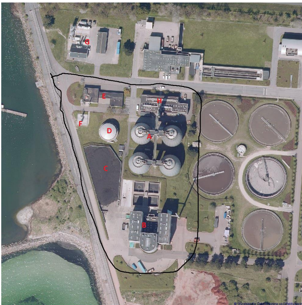
Billede 1: Tilsynet med Avedøre slamforbrændning omfatter aktiviteter inden for markeringen. Forbrændingsanlægget (markeret B) og over dette ses fire rådnnetanken(A). Oplag af slam(C) og biogasbeholder(D) er til venstre for disse I øverste venstre hjørne er opbygget et opgraderingsanlæg for gassen dannet i rådnnetankene(G) der muliggør at sende den opgraderede biogas på naturgasnettet. Hvidovre Kommune er tilsynsmyndighed på dette anlæg. Syd for gasmotoranlægget inklusiv olietanke(E) er affaklingsenhed(F) der udnyttes ved manglende kapacitet eller uheld. Værksted m.m. er i bygning(H)
