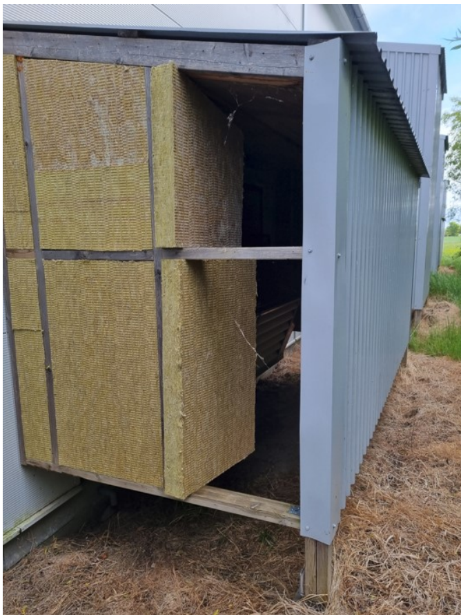
Isolering omkring ventilationsanlæggene.
