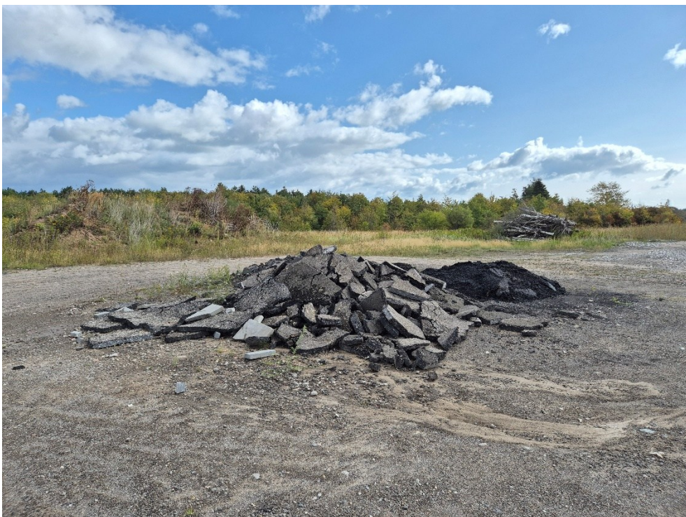
Figur 4. Asfalt til knusning.
