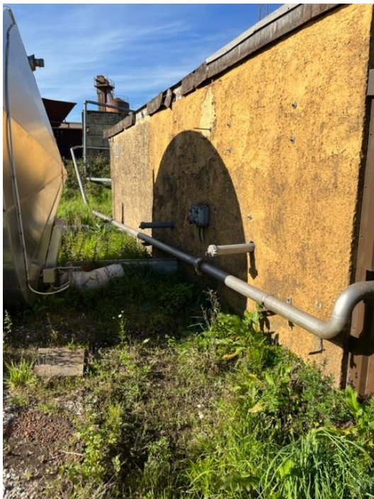
Foto 8: Bagside af bygning med brandslukningsudstyr. Fra de to studste monteres ved test slanger, der føres over ubefæstet areal til udendørs skumtanke (foto 9).
