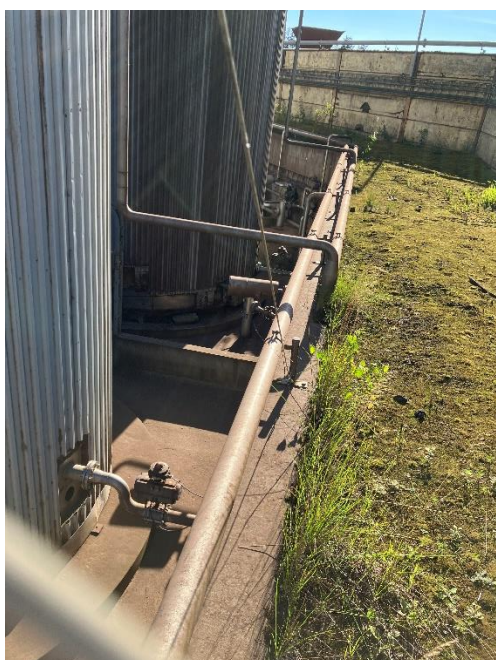
Foto 1: Tankgård af beton ved sprittanke.
