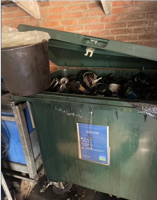
Billede 5. Opbevaring af oliefiltre indendørs og på tæt belægning.
