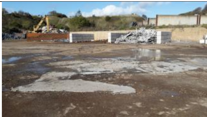
Belægning på oplagspladsen mellem shredder og metalhal.
