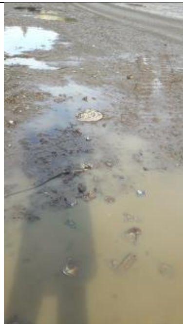
Afløb placeret udenfor randen af det befæstede areal mellem metalhal og dåsepakker.
