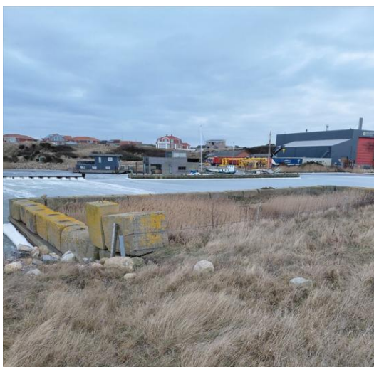
Foto 6. Afledningsbassin ved etape 1A.
