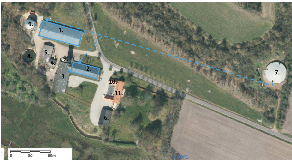
Figur 4. Fortanke og gylleledninger.
