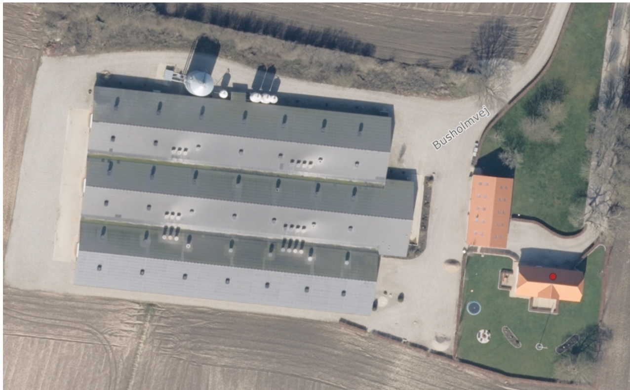
Ortofoto fra foråret 2021 der viser det gamle ventilationssystem på ejendommen.
