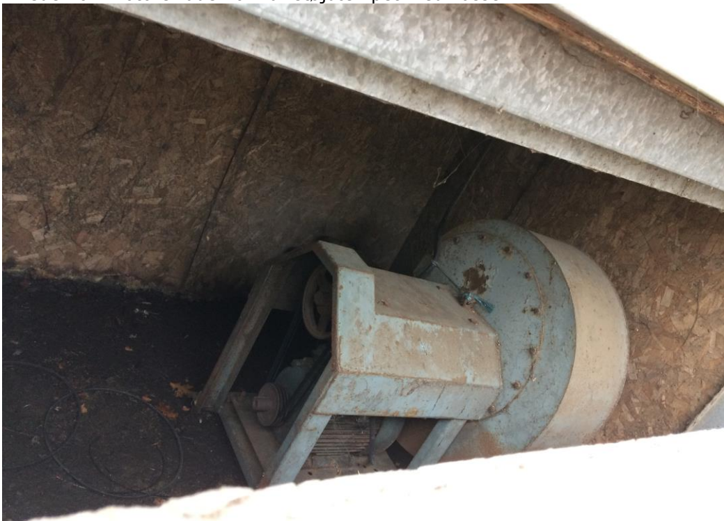
Billede 10 - Motorer udenfor var støjdempet med kasse.
