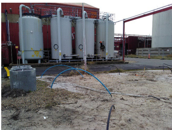
Eksisterende pejlerør i brøndring (C4P01, C4P02, C4P03), der flyttes ca. 2 m mod vest
