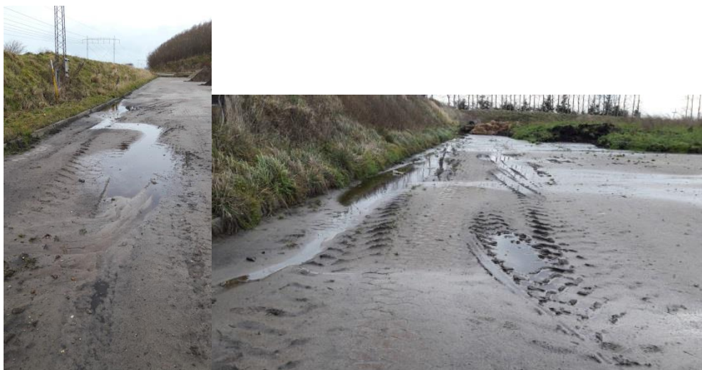
Figur 3 og 4: Lunker i SF stenbelægningen, midt for vold på henholdsvis syd- og nordside af pladsen.
