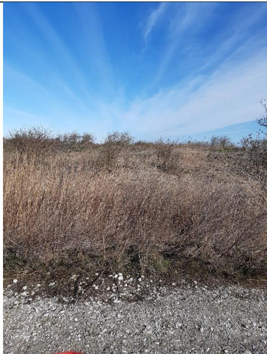
Foto 15: Bassin 11 set i retning fra den sydlige vold mod nord. Topkoten af deponeret materiale overstiger topkoten på omkringliggende volde.
