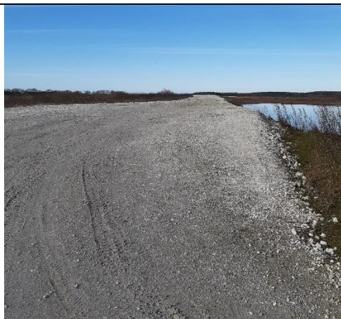
Foto 11: Østlig vendeplads mellem bassin 9 (th) og bassin 11 (tv) set mod vest.
