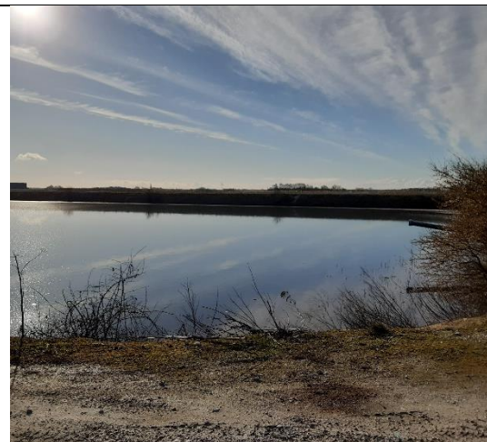
Foto 8: Bassin 8 set fra nordvestlige hjørne. Til højre ses rørføring fra bassin 9.
