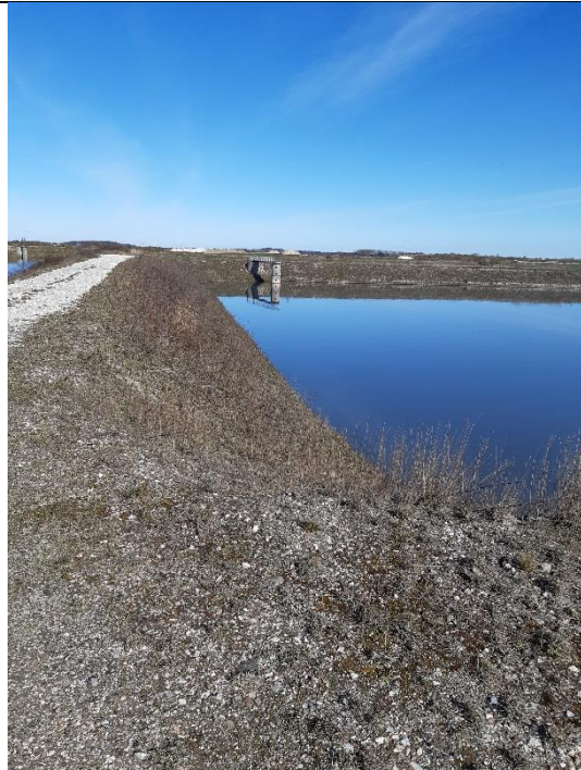
Foto 18: Bassin 31 set i retning fra bassinets sydvestlige hjørne mod nord. Bassin 24 ligger til venstre for volden. Mellemdapotet ses i baggrunden.
