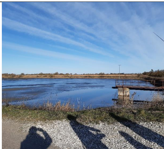
Foto 7: Bassin 6, østlig del, set i retning mod nord. Til højre ses rør, der tilleder jordsuspension.
