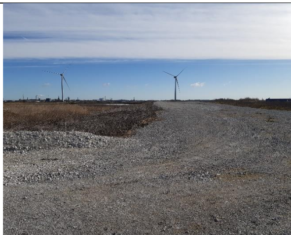
Foto 12: : Vestlig vendeplads mellem bassin 9 og bassin 11 set mod øst.
