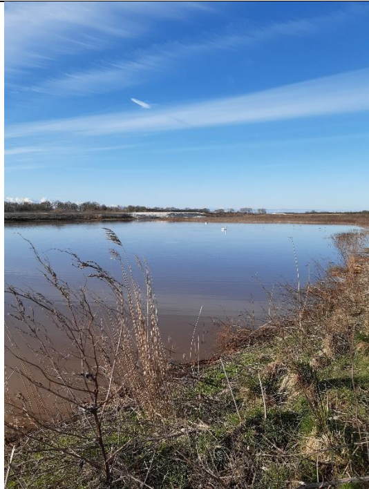
Foto 13: Udvidelse af vold mellem bassin 9 og 11. Set fra nordøstlige hjørne af bassin 9 i retning mod sydvest. Udvidelse af volden ses i den modsatte ende af bassinet.
