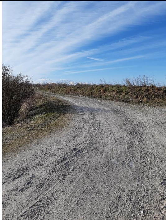
Foto 14: Forhøjelse af vold omkring bassin 9. Set fra volden langs det nordøstlige hjørne af bassin 9. Til venstre ligger bassin 8. Lige frem den forhøjede vold omkring bassin 9.
