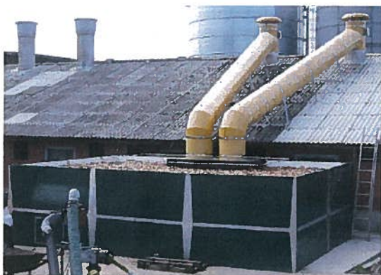
Figur 1. BIO-REX Hartmann Bio-Filteret tilkoblet slagtesvinesektionen, hvor afprøvningen blev gennemført. (Foto: Anders Leegaard Riis, billede nr. 1013).
