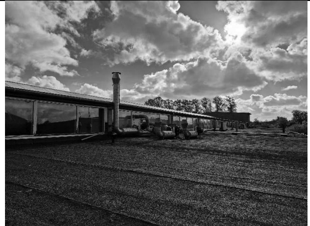
Foto 4 Afkast på tag af bygning. Nyt afkast ca. 2 meter over tag. Hvis produktionen øges, skal det vurderes om de gamle afkast skal forhøjes.
