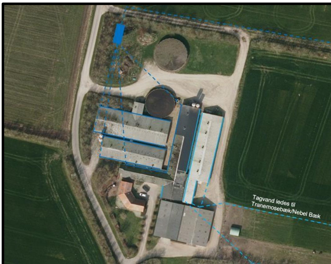
Figur 9. Tagvand på Klintingvej 111
