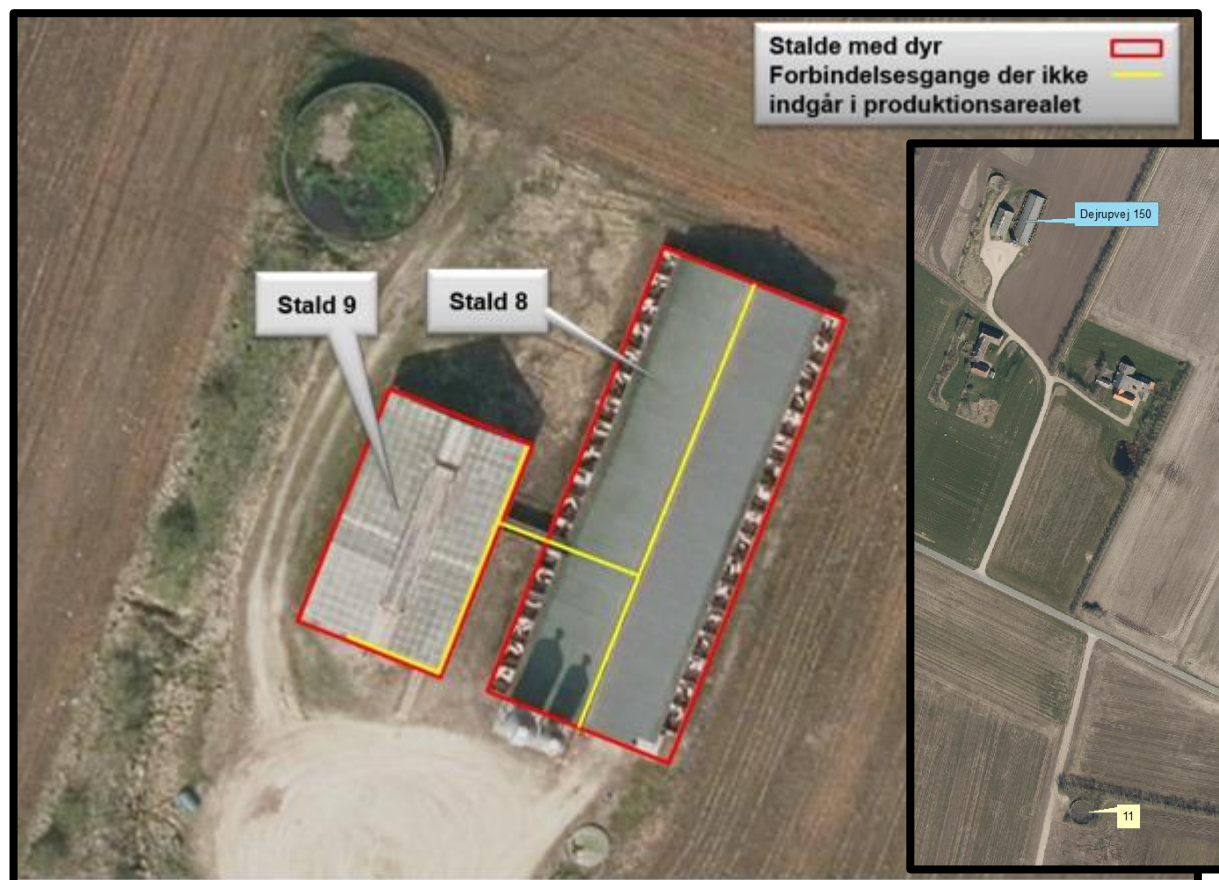
Figur 4. Oversigt over husdyrbrugets staldbygninger på Dejrupvej 150.
