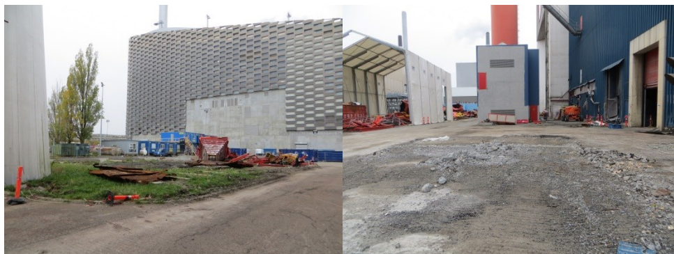
1. Tidligere tankgård til 3 ammoniaktanke (kun 2 tanke var i brug)
