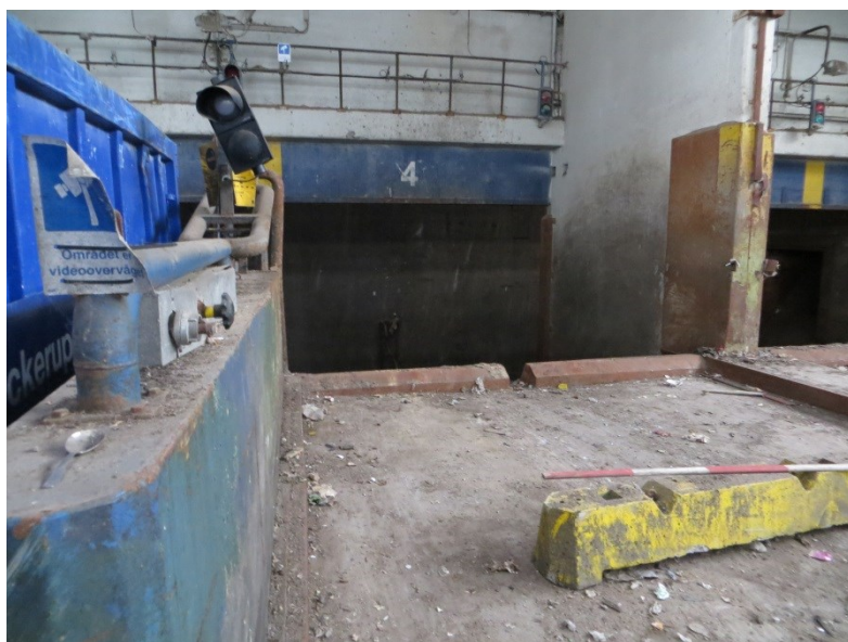
Aflæsseplads til affaldssilo.. ARC eftersender billede af fribund af silo.
