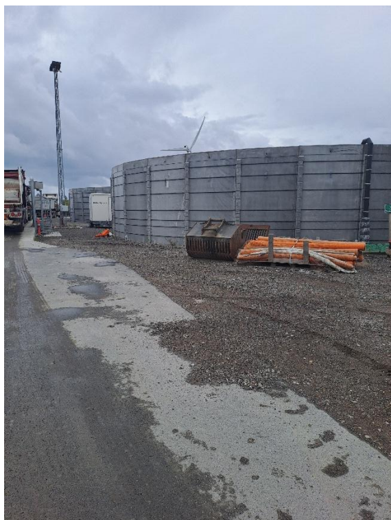
Opsamlingsbassiner mellem B-vej og Z-vej.
