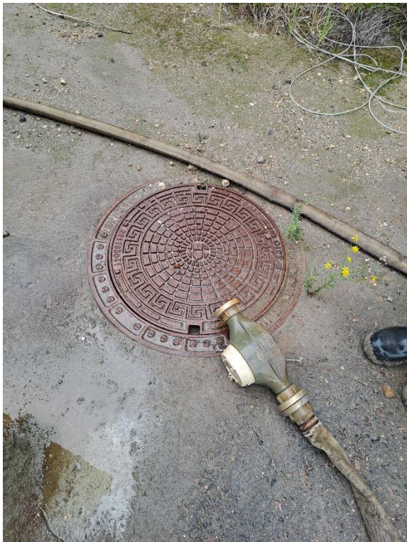
Afledningspunkt. Her kan udtages en prøve til analyse også
