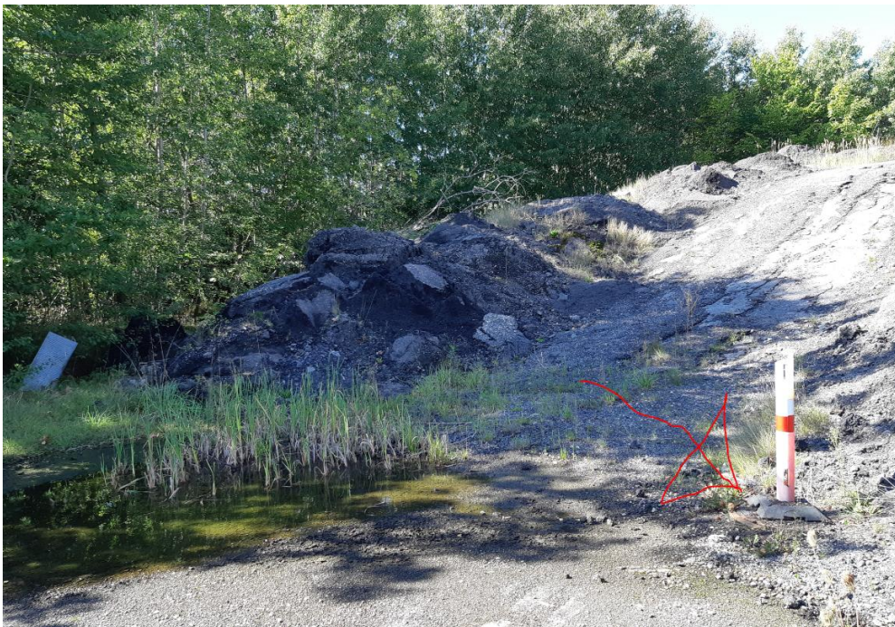
OU2, der tidligere var begravet under asfaltbunke
