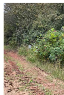
Nedsivning i bevokset vold ved ler lager
