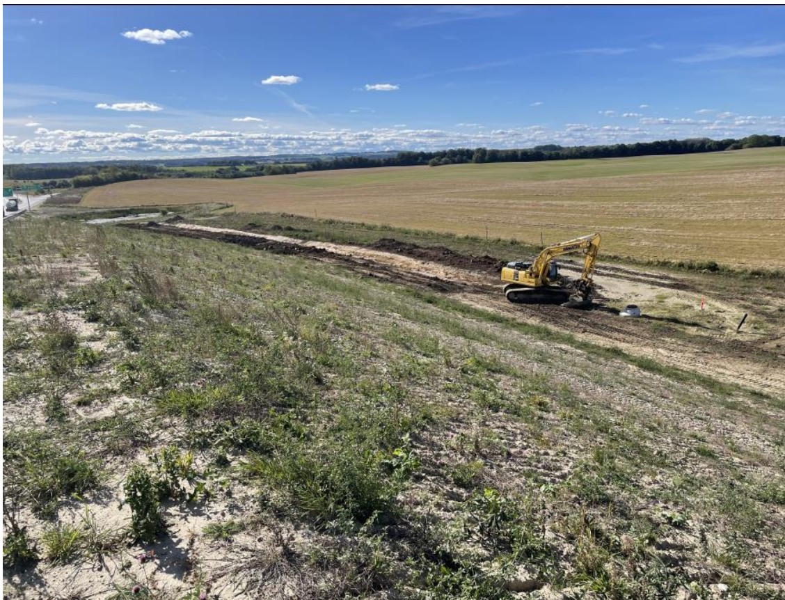
Billede 8. Etablering af afvandingsgrøft.
