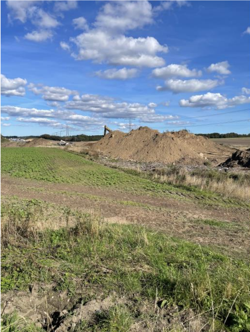
Billede 5. Opgravning af jord i forbindelse med påbegyndelse af etablering af støjvolden i Mundelstrup.
