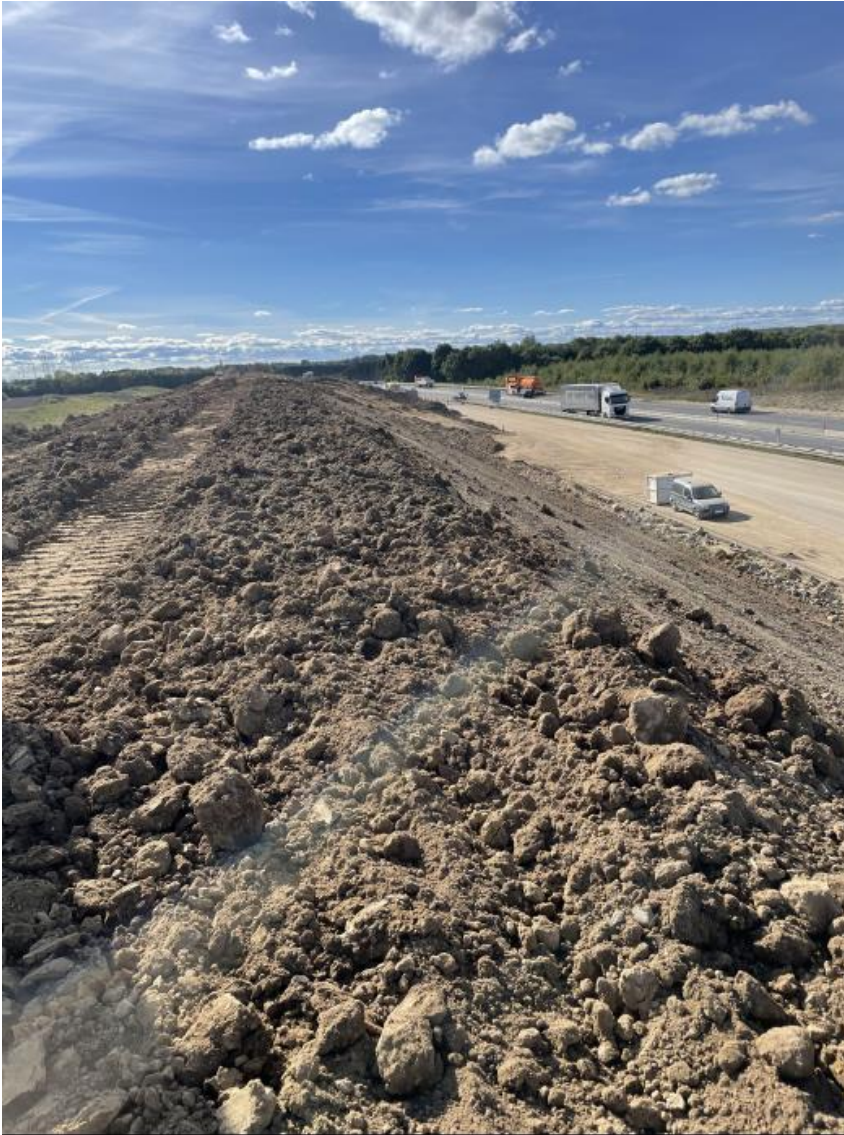
Billede 6. Støjvold i Geding, hvor der mangler kalkstabilisering i toppen
