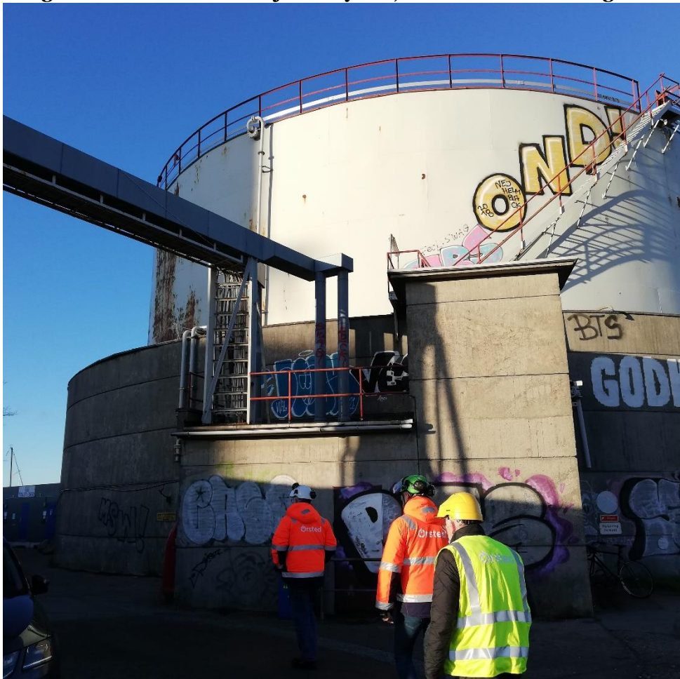
Bilag 12: Letolieank er ikke fjernet fysisk, men fremstår tørt og afblændet.
