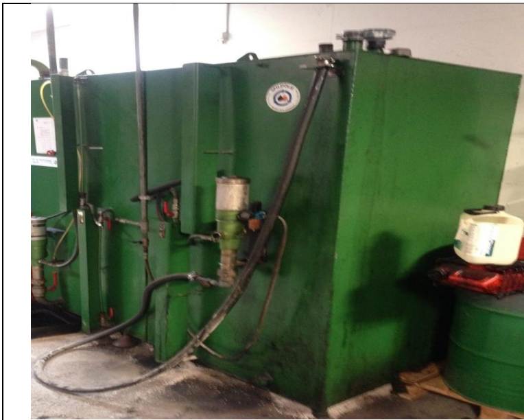
Fig. 1 To identiske ståltanke fra 1993
