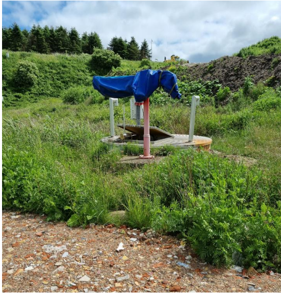
Billede 10 og 11. Brønd med flowmåler fra enhed 2.1 og 2.2. Brønden er tømt for overfladevand men elinstallationer endnu ikke repareret.
