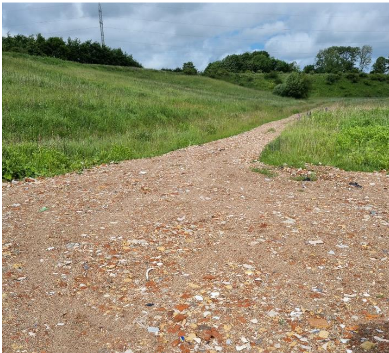
Billede 12. Midlertidig vej etableret af nedknust bygningsaffald.
