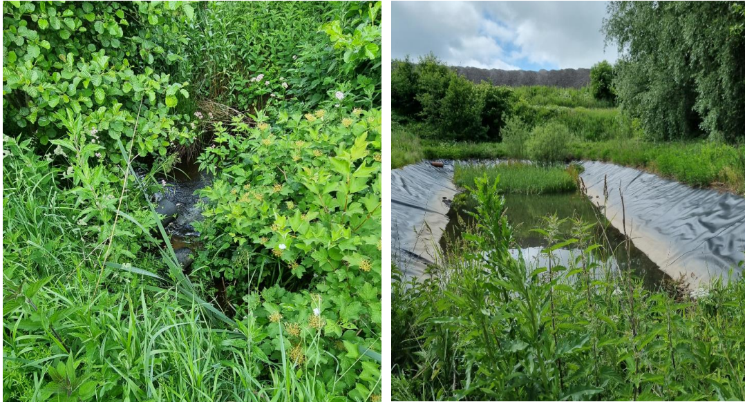
Billede 13 og 14. Udløb fra forsinkelsesbassin til Ribberholt Bæk samt forsinkelsesbassin. Bassinet modtager overfladevåd fra de rene områder på genbrugspladsen.
