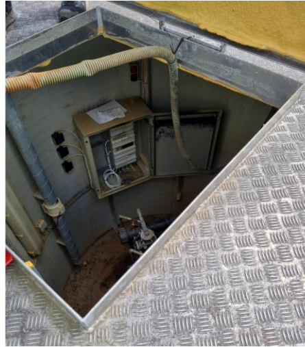
Billede 10 og 11. Brønd med flowmåler fra enhed 2.1 og 2.2. Brønden er tømt for overfladevand men elinstallationer endnu ikke repareret.
