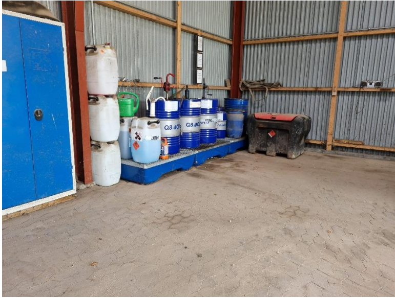
Billed 3. tanke med olieprodukter placeret på spildbakker. Ved siden af står den mobile olietank.
