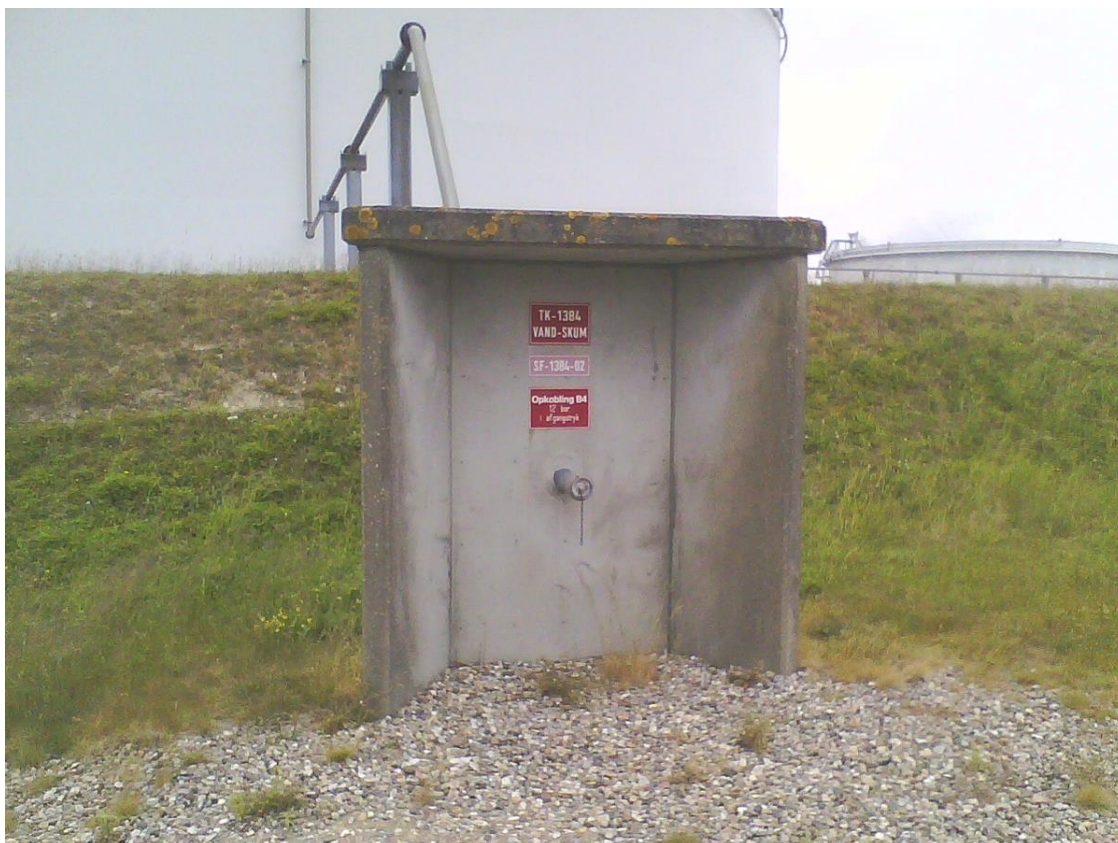
Figur 15: Billede af skumniche til ethanol tanken TK-1384. Billede er taget fra syd mod nord.
