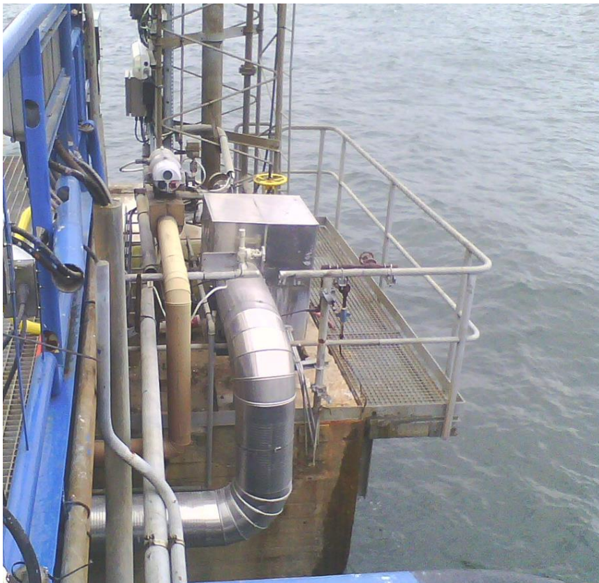
Figur 4: Billede af skuminstallation på Pier C – nederste del. Billede er taget fra syd md nord.
