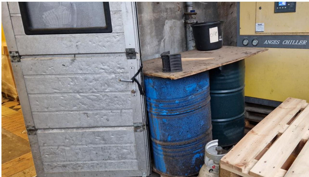
Spildolie i tromler uden spildbakke.
