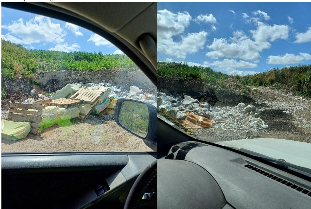
Figur 2: Indpakket asbestaffald og knust asbestaffald foran deponeringsfronten
