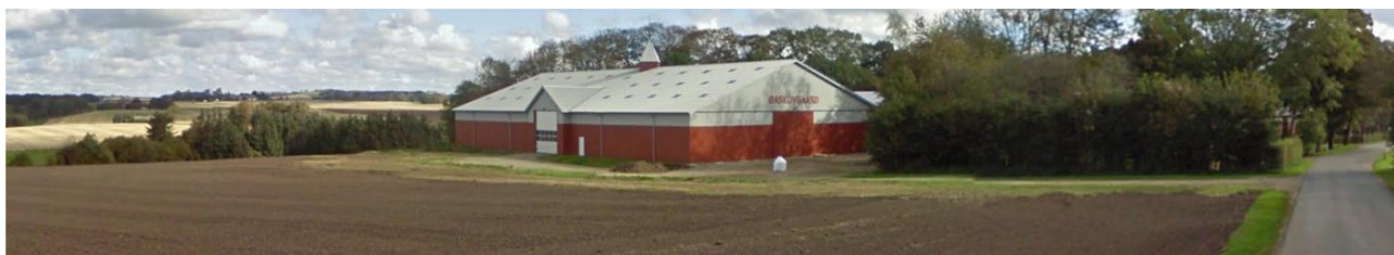
Lade beliggende på nordside af Kirkevej.
