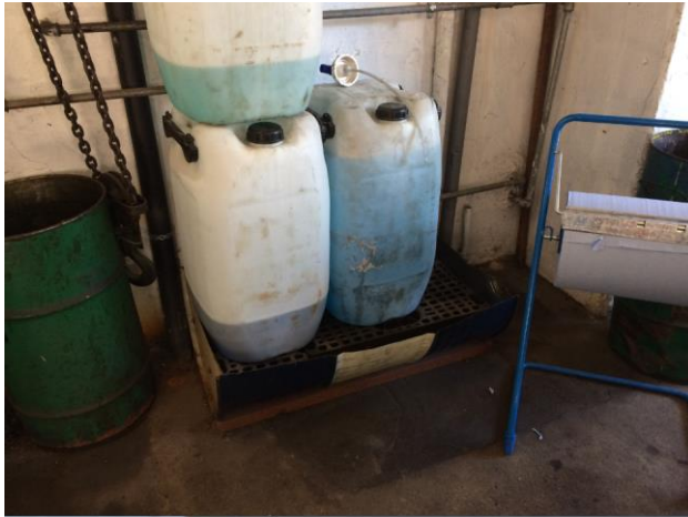
Opbevaring af sprinkler- og kølervæske
