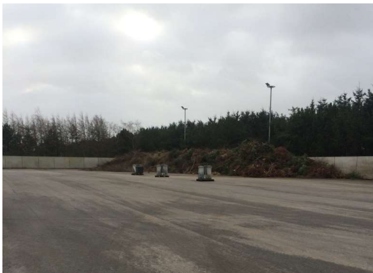
Figur 1: Pladsen til aflevering og opbevaring af have- og parkaffald.
