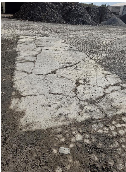
Område i belægningen som er udbedret
