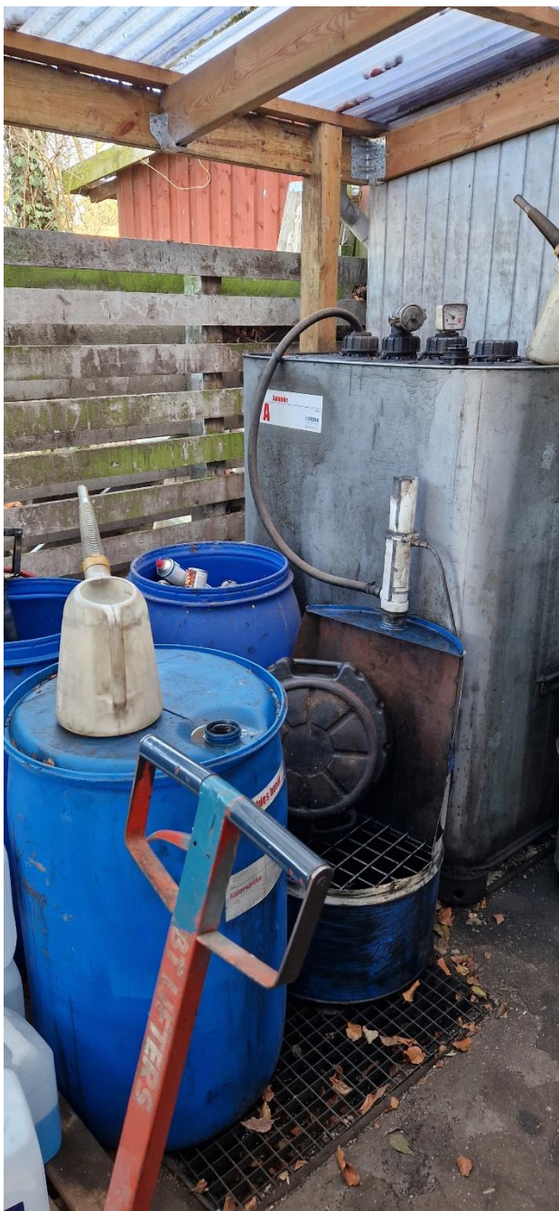
Spildolie i tank med dobbeltvæg og øvrigt farligt affald over opsamlingssump.
