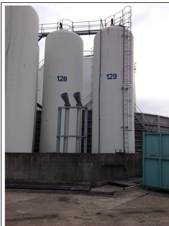
TV: Glasfibertanke hvor fiskeensilage er planlagt overpumpet forud for udlevering til tankbil. TH: Kig ned i tankgård for T120.
