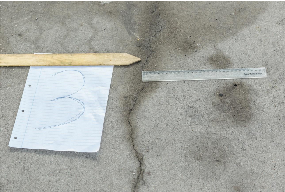
Foto 9 Punkt 3: Revne i betonbelægning på salgspads (set fra vest).
