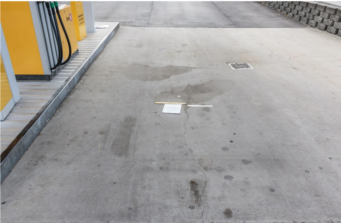
Foto 8 Punkt 3: Revne i betonbelægning på salgsplads (set fra vest).
