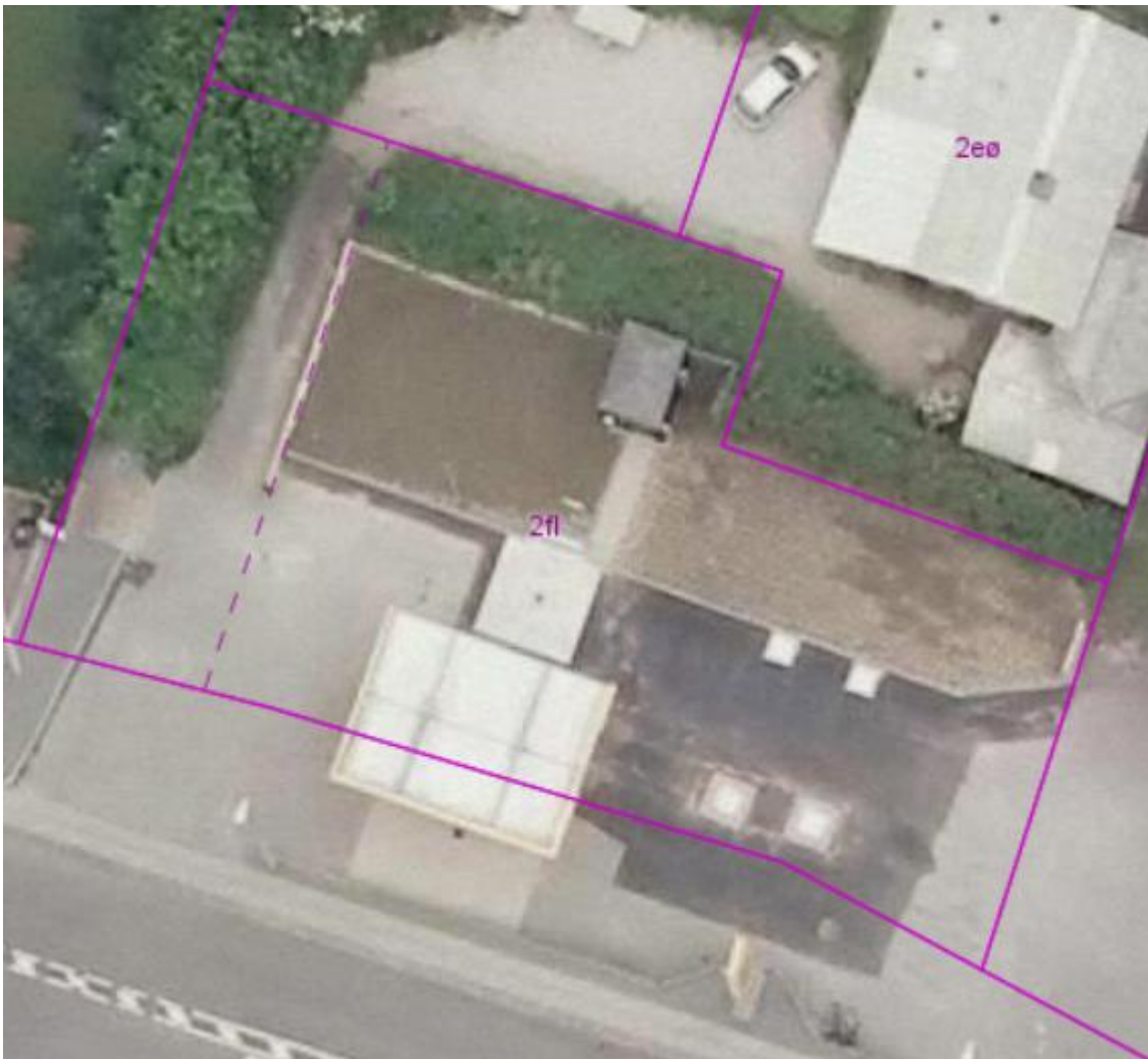
Figur 1 Luftfotos af tankstationen (luftfoto fra 2014).
