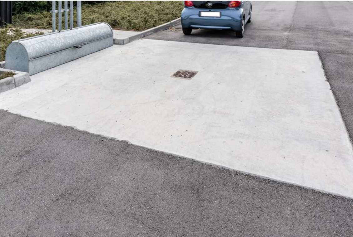
Foto 3 Påfyldningsplads med betonbelægning (set fra vest). Ingen revner.
