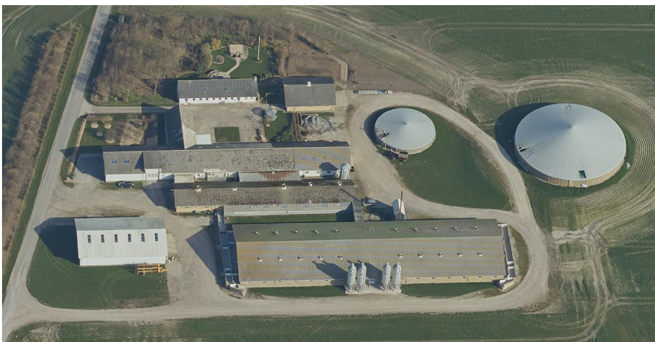
Figur 2: Mellergårdsvej 66 set fra syd. Kilde Skråfoto.dk
