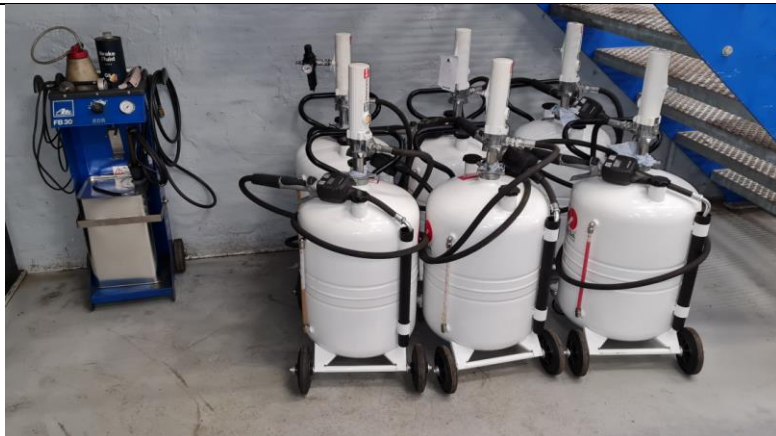
Billed 1. på billedet ser man autoværkstedets oplag af olie i vogne, hvor det blev oplyst ved det digitale tilsyn, at vognene bliver opbevaret i et lager uden afløb og med opkant.
