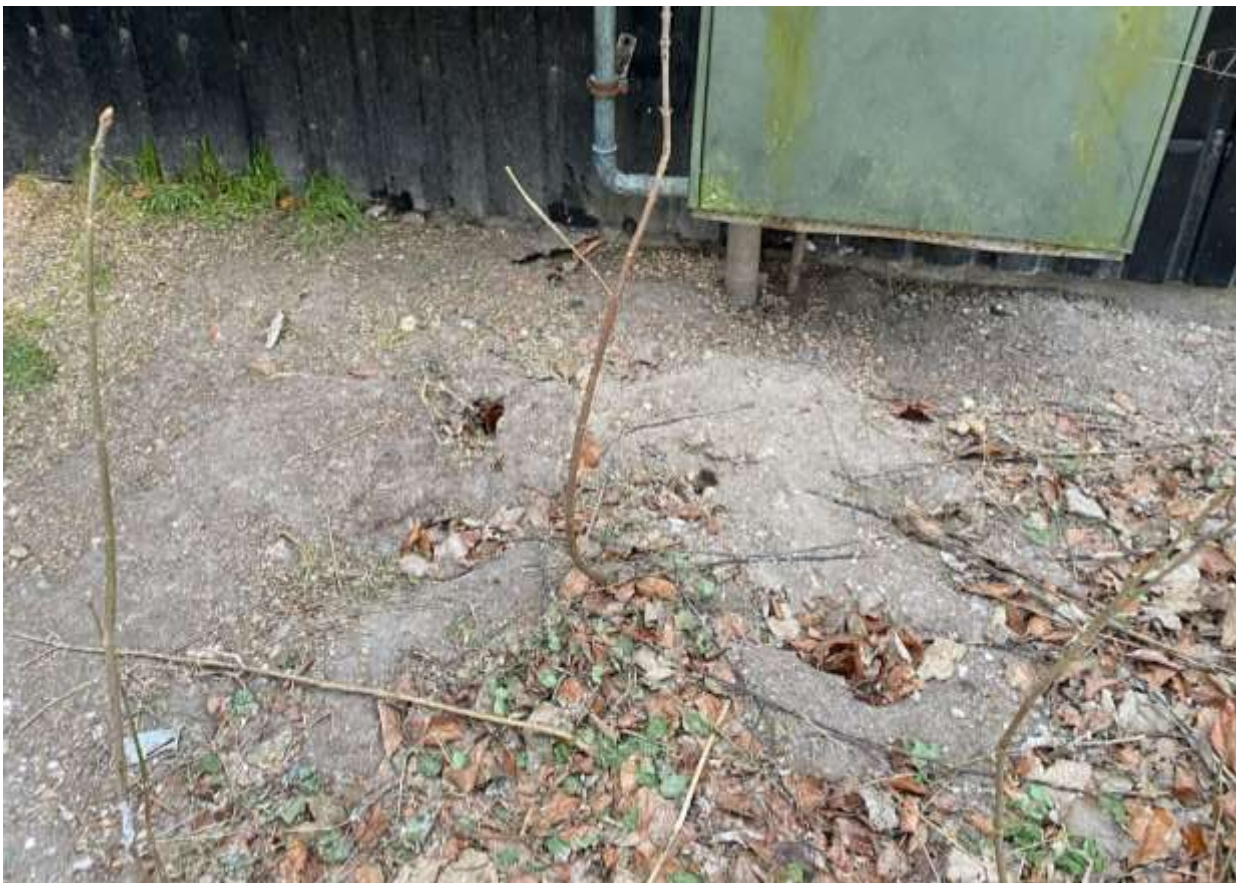
Foder under soklen fra kornlageret.
