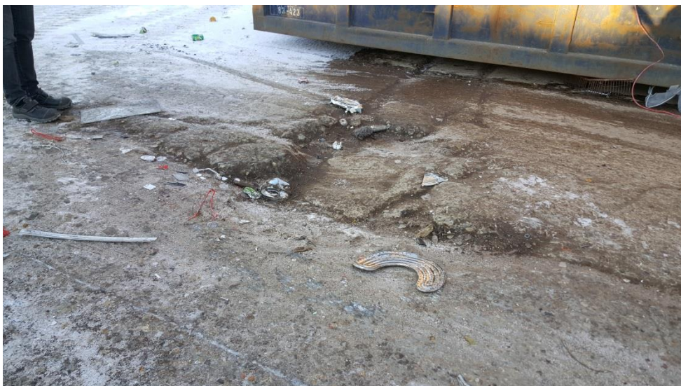
Figur 4: Betonbelægning på areal for oplag og omlastning af metalaffald
