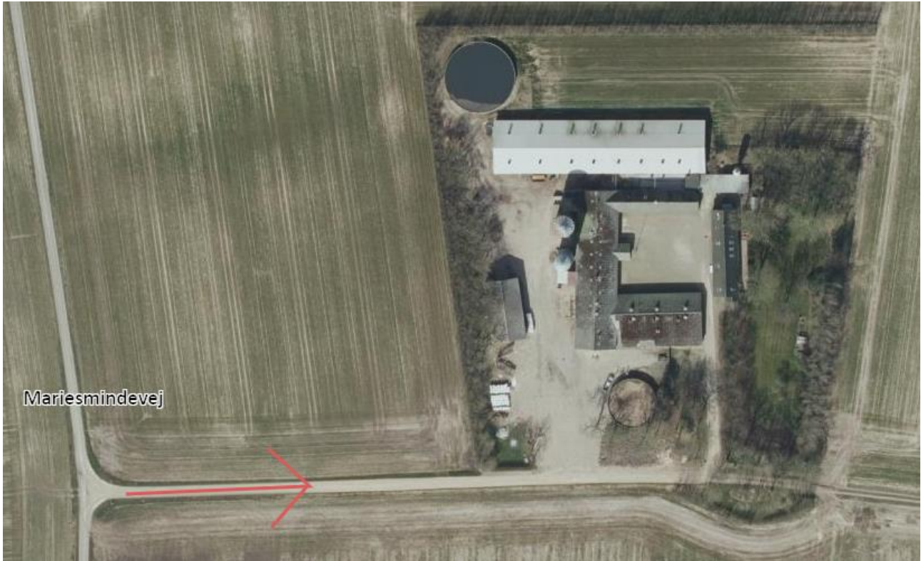
Figur 4 Transport til og fra anlægget foregår via Mariesmindevej.
