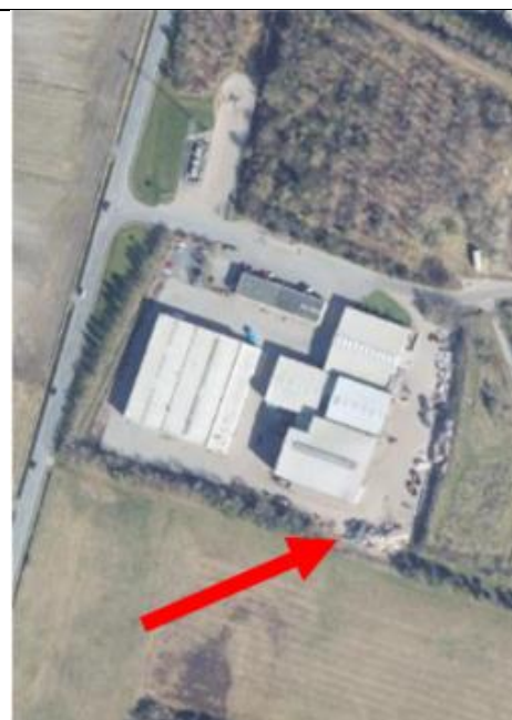
Figur 5. Lokalisering af afstrømning af overfladevand til jord.
